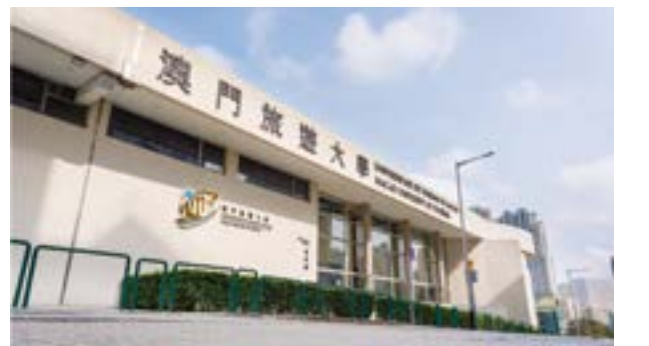
展望楼是澳门旅游大学位于氹仔的综合教学大楼之一，设有课室、图书馆、会议场地、培训中心、餐厅、停车场等设施。
